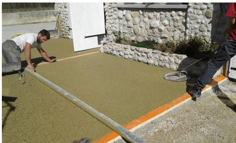
Le béton est préparé en centrale, il arrive sur le chantier dans une toupie, la pose se fait brouette par brouette à la main.
